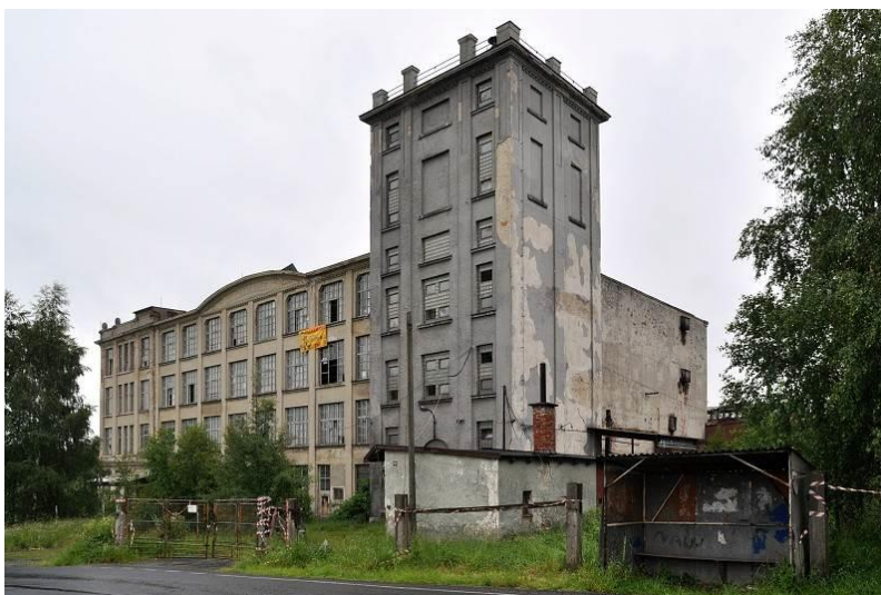
Obr. č. 30: Objekt bývalé továrny v Libě
