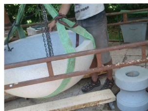
Demontáž přelivné vázy
