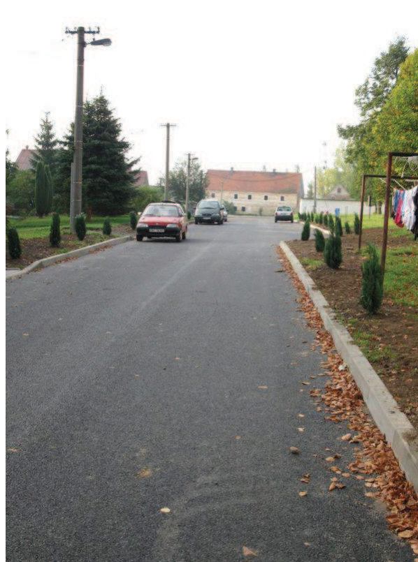
Po ukončení realizace
