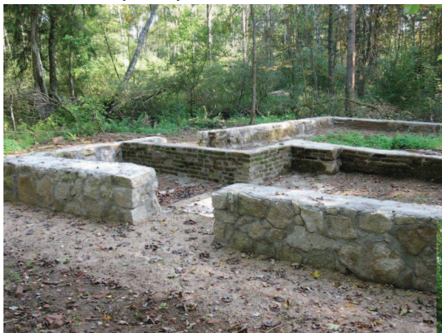
Obnovené základy zaniklých domů
