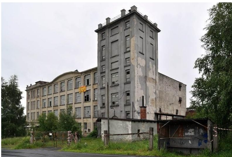
Obr. č. 30: Objekt bývalé továrny v Libě
